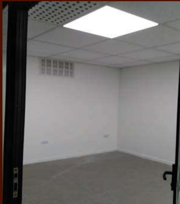
Celosía interior. Ventilación hacia escotilla y cielo
