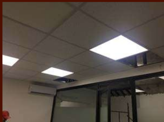
Ventilaciones de cielo.
